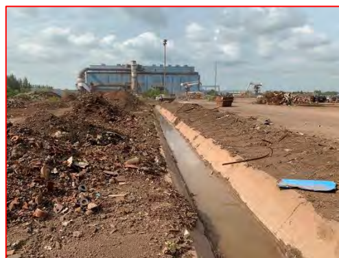
ภาพที่ 2.2-12 รางระบายน้ำฝน ในพื้นที่ลานกองเศษเหล็ก
