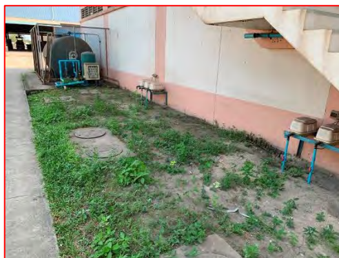
ภาพที่ 2.2-6 ถังบำบัดน้ำเสียสำเร็จรูป
