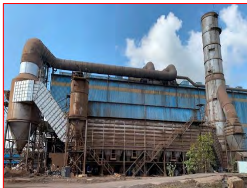
ภาพที่ 2.2-2 ระบบ Bag Filter House
