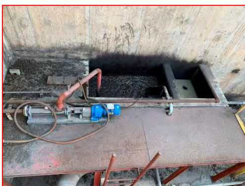
ภาพที่ 2.2-9 ระบบดักแยกคราบน้ำมัน
