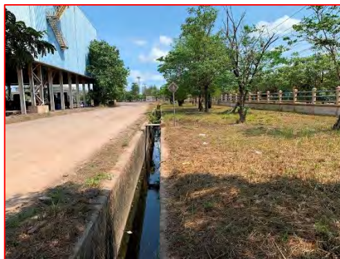
ภาพที่ 2.2-14 รางระบายน้ำฝนขนานไปกับ แนวรั้วรอบพื้นที่โครงการ
