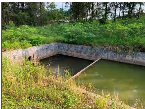
ภาพที่ 2.2-13 บ่อดักตะกอนลานกองเศษเหล็ก
